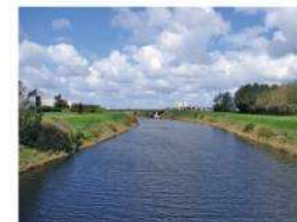
Berges du canal exutoire
