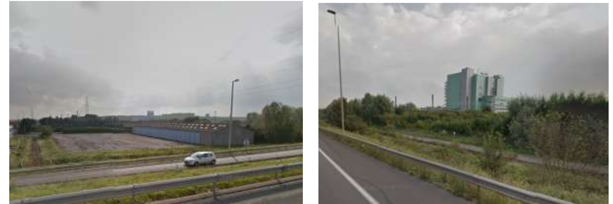
Vue depuis l'autoroute A16 (Grande-Synthe) (Source : MEDIATERRE Conseil, visite du 20/03/2015)
