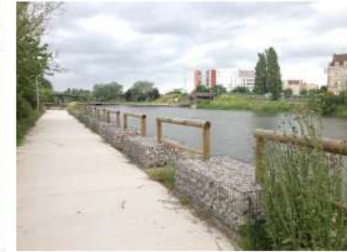
Photo 3 : Aménagement des berges du canal de Jonction.
