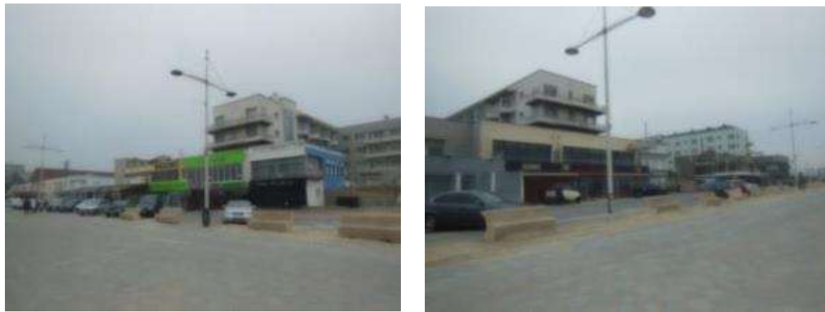
Maisons de front de mer- Quartier Malo (Dunkerque) (Source : MEDIATERRE Conseil, visite du 20/03/2015)
