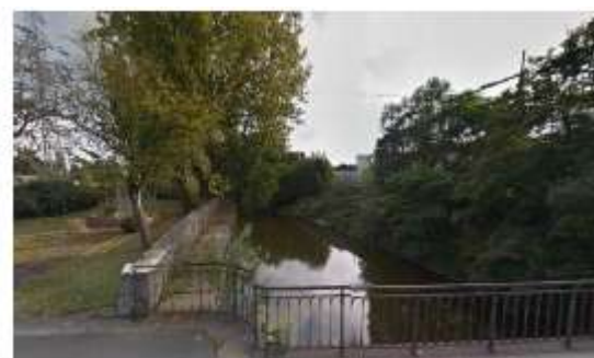
Photo 10 : Canal des Moères au droit de la station des 4 écluses.
