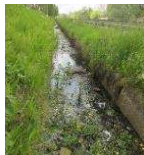
Fossé artificiel le long de la RD601
