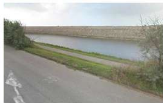
Photo 14 : Canal Exutoire à proximité de la station Tixier.
