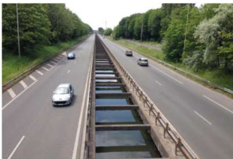
Photo 5 : Ancien canal de Mardyck et RD 401.
