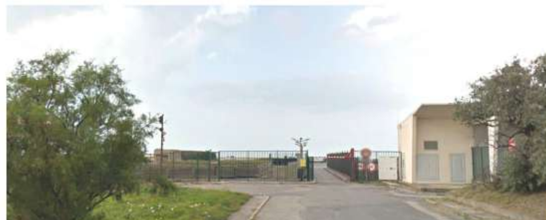
Photo 15 : Station de pompage Tixier.
