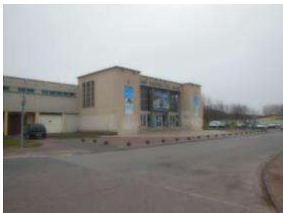
Piscine Paul Asseman (Source : MEDIATERRE Conseil, visite du 20/03/2015)
