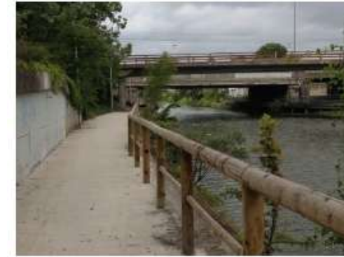
Photo 2 : Aménagement des berges du canal de Jonction.
