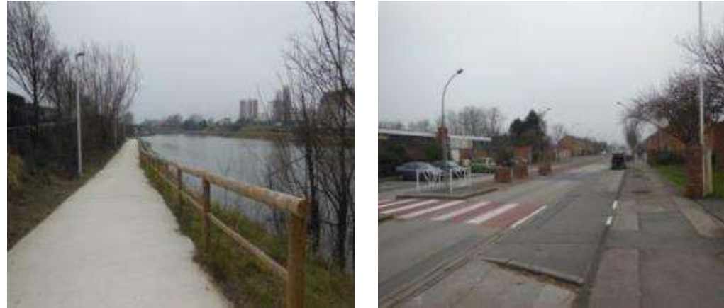
Piste cyclable et piétonne en bord de canal et trottoirs dans un quartier pavillonnaire (rue du banc vert) (Source : MEDIATERRE Conseil, visite du 20/03/2015)
