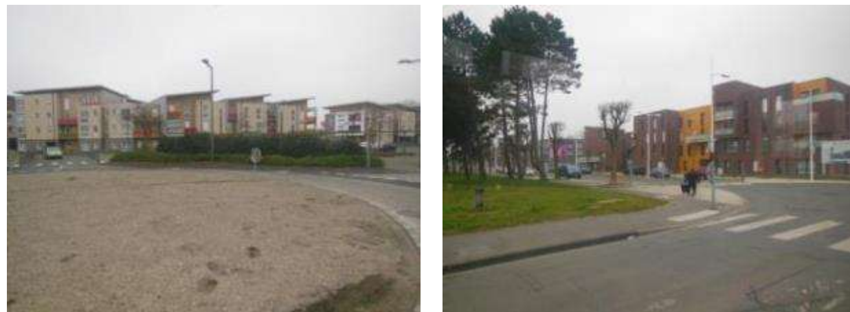
Nouveaux logements collectifs de Grande Synthe (Source : MEDIATERRE Conseil, visite du 20/03/2015)
